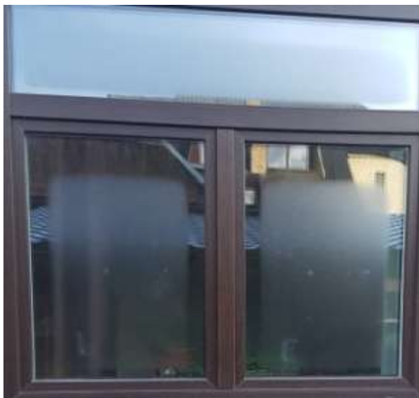
Pavyzdys. Kondensato susidarymas ant stiklo paviršiaus
