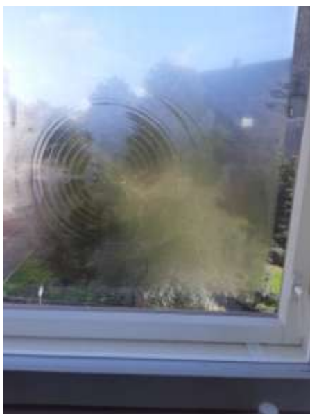
Pavyzdys. Vakuminių prisiurbėjų, tarpinių žymės ant stiklo paviršiaus
