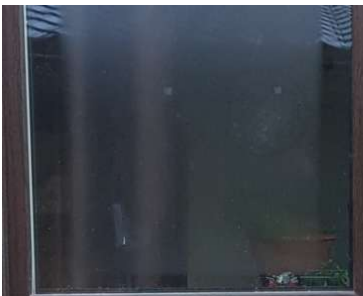
Pavyzdys. Vakuminių prisiurbėjų, tarpinių žymės ant stiklo paviršiaus
