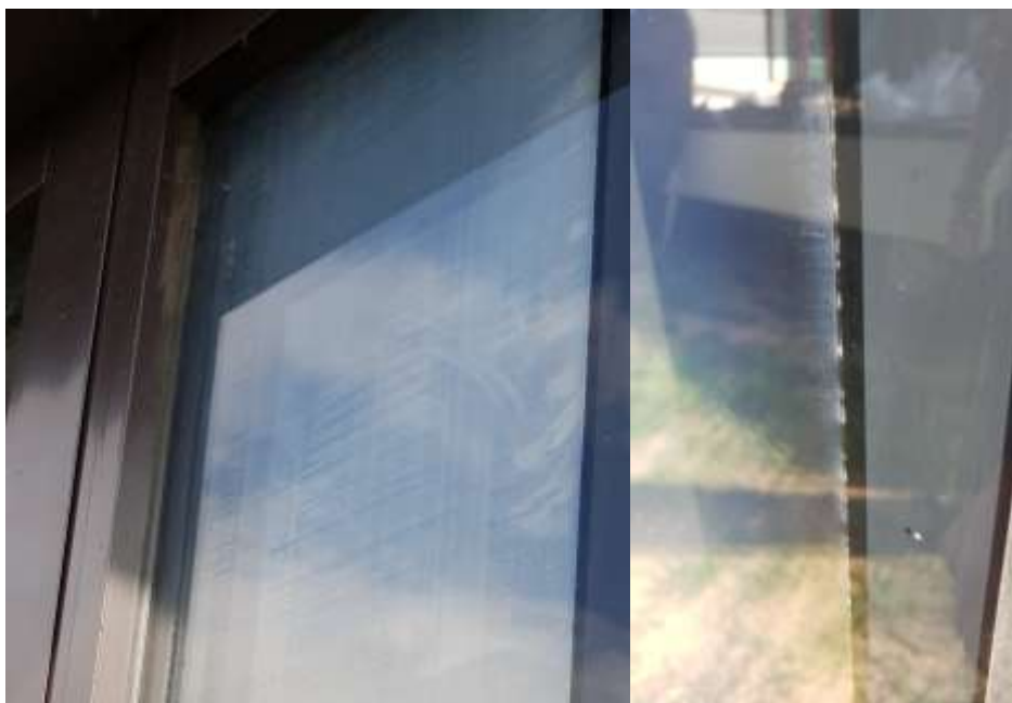
Pavyzdys. Medžiagų nesuderinamumo požymiai stiklo paketo viduje
